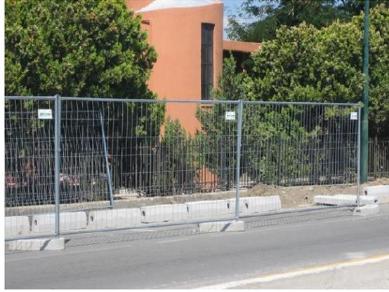
Foto 1: Esempio di rete di recinzione x delimitazione traffico da posizionare lungo la Via Deledda
