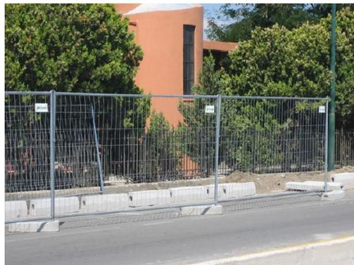
Foto 1: Esempio di rete di recinzione x delimitazione traffico da posizionare lungo il Viale Europa
