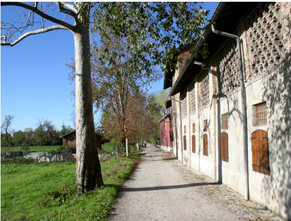
Particolari delle rogge e la strada che costeggia la Cascina Olgetta
